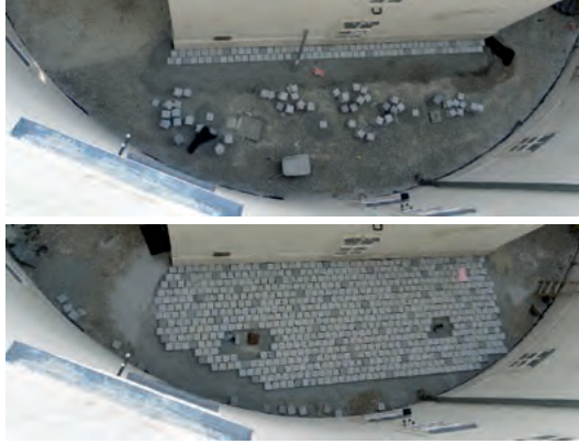
Pflasterung des Hofes im Narrenturm (Sommer 2018)
